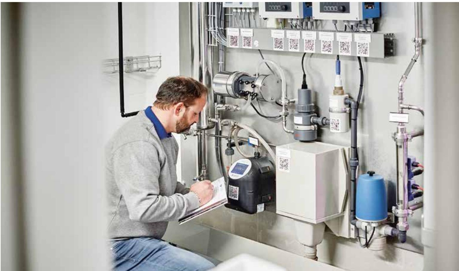
53 – An den wichtigsten Stellen bei der Wassergewinnung und den Abgabestellen sind In-Prozess-Messungen zur ständigen Überwachung installiert.
