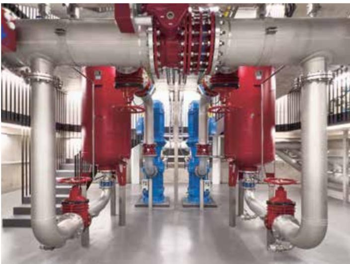
15 – Es besteht je eine Verbindung zur Freispiegelleitung Aaretal 1 (grün) und zur Druckleitung Aaretal 2 (blau).
