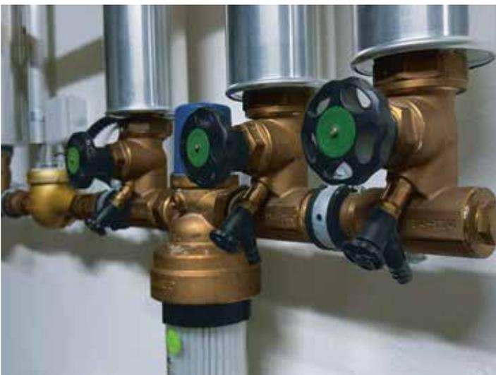
Problematisch sind überdimensionierte Stichleitungen zu Liegenschaften, insbesondere, wenn diese für einen allfälligen Brandfall (Sprinkleranlagen) erstellt wurden und der normale Bezug minimal ist.
