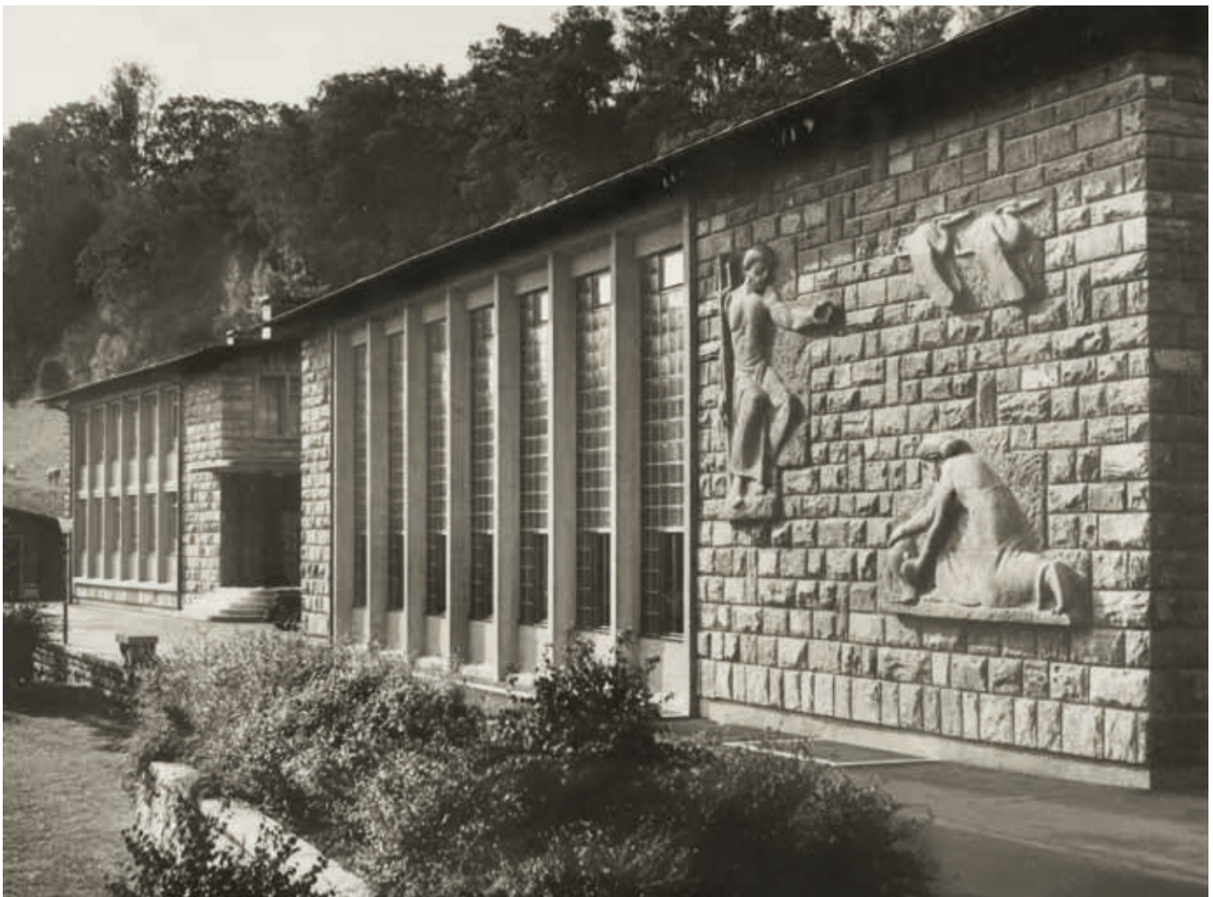
Pumpwerk Schönau Gesamtansicht.
