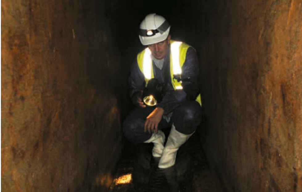
Ein Kontrollgang im Stollen zwischen Oberscherli und Schlatt der Scherli- talleitung.
