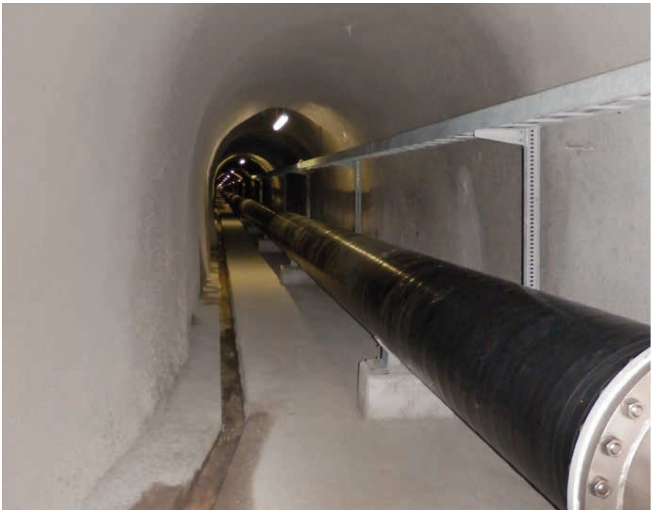
Stollen von Wabern (Bächtelen) zum Reservoir Gurten.
