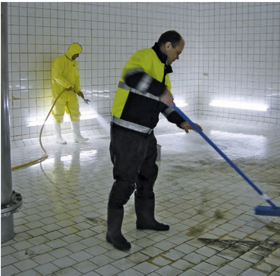
Reinigung im Hauptpumpwerk Belpau.
