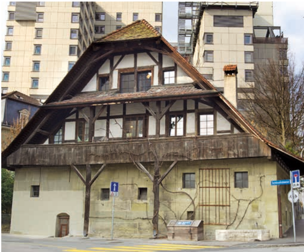
Das Brunnenpump- haus an der Brunn- mattstrasse in Bern heute.
